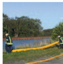
Introduction de la barrière dans l'eau
